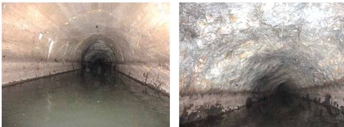
а) концевая часть –оштукатуренная; б) средняя часть туннеля - естественная скала
