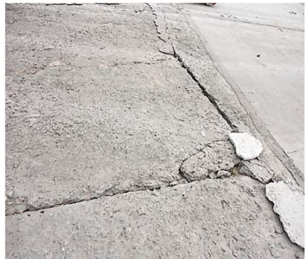
Рисунок 7 - Крепление верхового откоса плотины монолитными плитами Обследование бермы плотины показало, что 2 и 3 бермы от гребня плотины не окончательно сформированы и спланированы, низовой откос не засеян многолетней травой, 4 ярус (рис.8,а) и 5 ярус не спланированы (рис.8, б).
