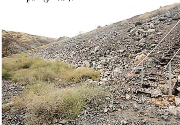
Рисунок 9 - Состояние низового откоса плотины
