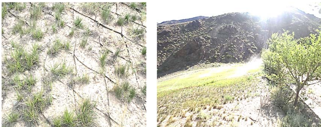
Рисунок 1 - Крепление низового откоса многолетних травами и их полив дождеванием
