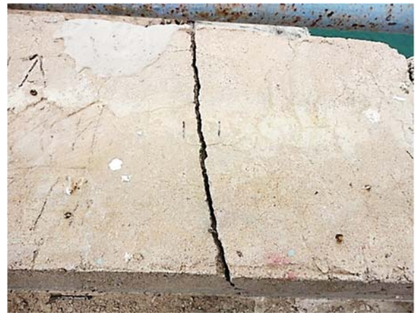
Рисунок 6–а)раскрытие температурно-осадочного шва и б)береговое сопряжение правого крыла входного оголовка
