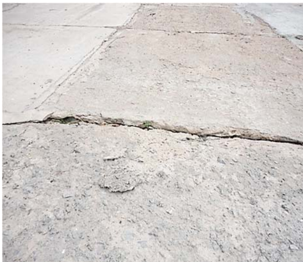
Рисунок 7 - Крепление верхового откоса плотины монолитными плитами Обследование бермы плотины показало, что 2 и 3 бермы от гребня плотины не окончательно сформированы и спланированы, низовой откос не засеян многолетней травой, 4 ярус (рис.8,а) и 5 ярус не спланированы (рис.8, б).
