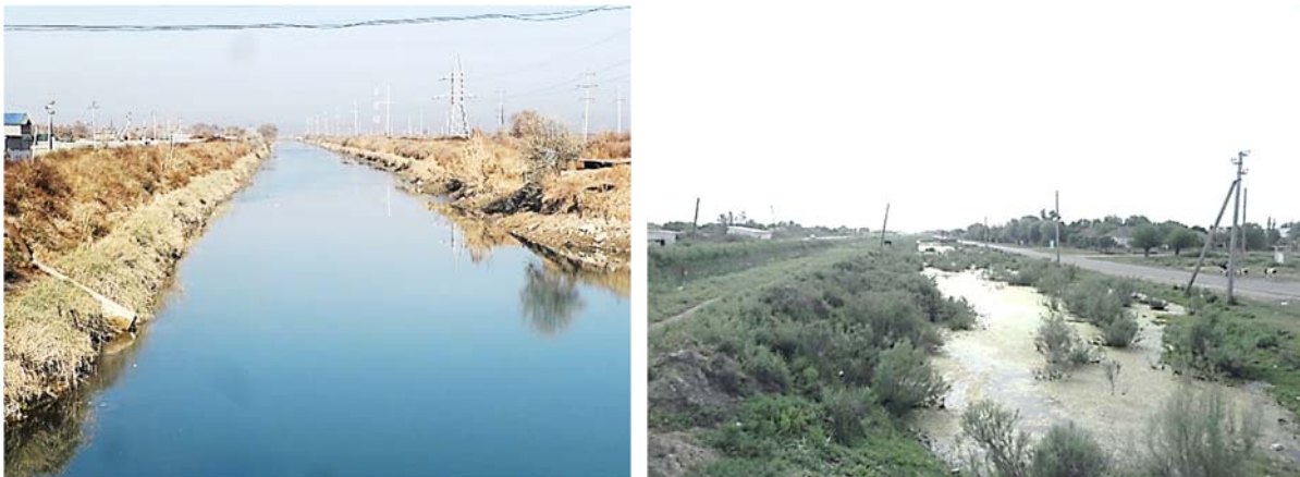
Рисунок 2 – Магистральный канал «Достык» и профильтровавшаяся вода через дамбу межхозяйственного канала К-30 (Махтааральский массив)
