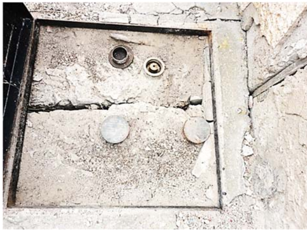
Рисунок 6–а)раскрытие температурно-осадочного шва и б)береговое сопряжение правого крыла входного оголовка
