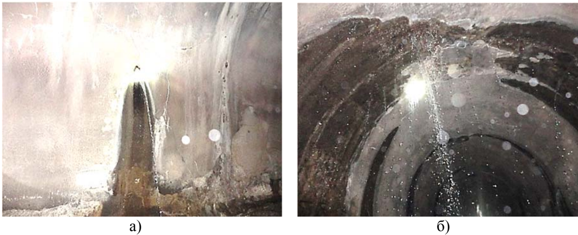
Рисунок 2 - Выход фильтрационных вод из боковых стенок (а) и купола(б) туннеля шахтного водосброса
